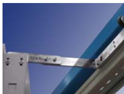
Selector de cierre puertas doble hoja Closure selector for two leaf-doors. Sélecteur de fermeture pour portes double-ventaux
